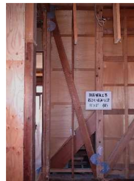
プロジェクトTOUKAI-0実施建物の状況
