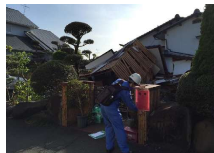
応急危険度判定活動の様子(熊本地震)
