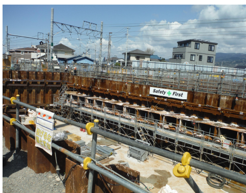
J R 交差部 (JR施工)
