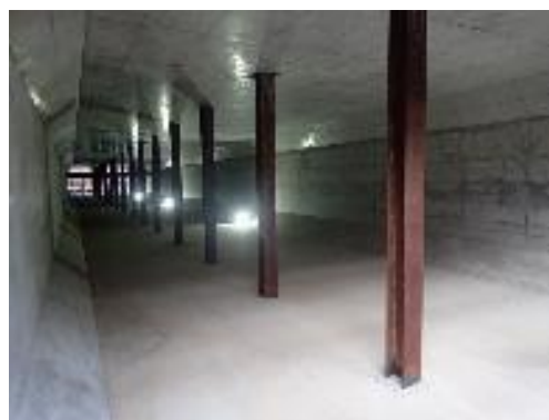
函体内部 (県施工)
