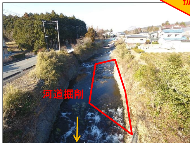
滝見橋下流(完了)
