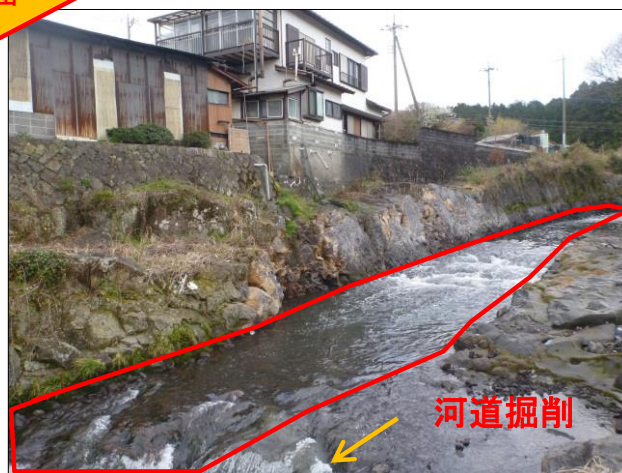
滝見橋から高橋(施工中)
