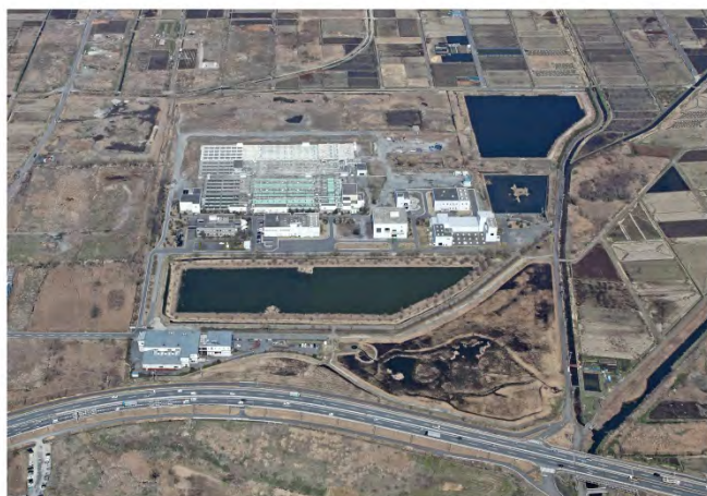
狩野川西部浄化センター
