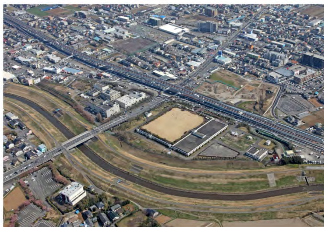
狩野川東部浄化センター
