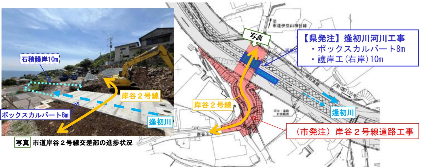
写真 市道岸谷2号線交差部の進捗状況
