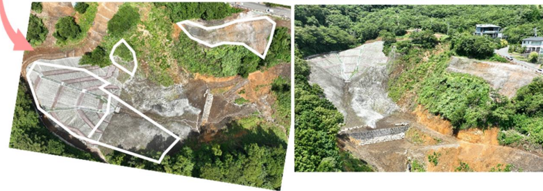
↑ 源頭部土砂撤去工事完了（令和5年8月8日撮影）
