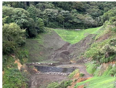
↑ 源頭部土砂撤去工事完了（令和5年9月21日撮影）
