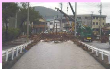
【伊東市】 流木等が溜まり、川が塞ぎ止められた伊東仲川 杉本橋
