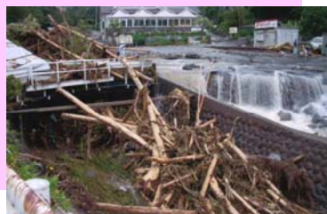
【伊東市】 流木等が溜まり、川が塞ぎ止められた烏川 大山橋
