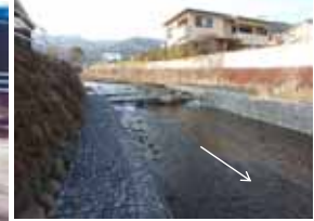
根継工、河川断面拡幅状況
