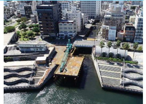
初川水門工事状況（令和5年9月時点）
