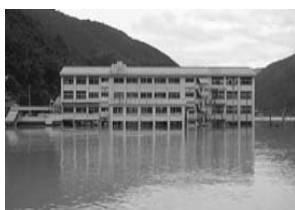
H26.8避難所2階の浸水 (徳島県)
