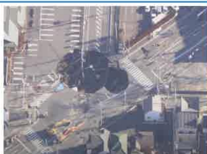
1月31日時点の事故現場の状況
