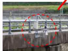
危機管理型水位計の設置
