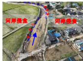
水衝部等の河岸侵食
