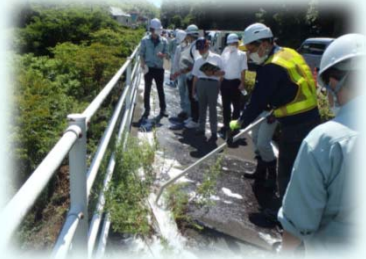
高温の泡による除草対策工法
