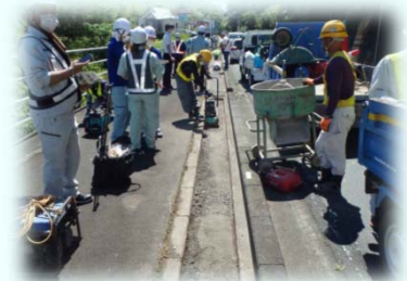
土系舗装による防草対策工法
