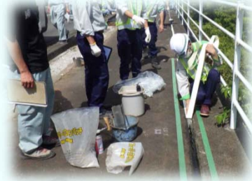
構造物目地防草対策工法
