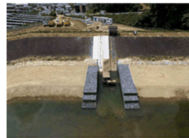
対策工事実施後（夜水沢池）
