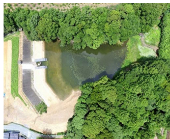
夜水沢池（完成）
