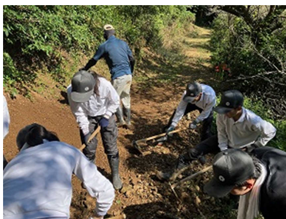
（作業道の整備）
