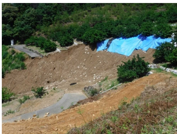
（北区三ヶ日町のみかん園被災状況）
