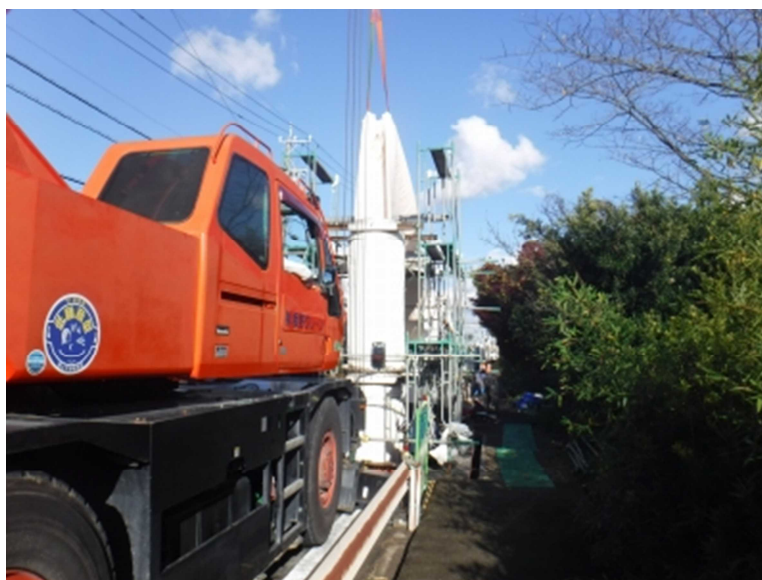
施工状況（更生管の挿入）
