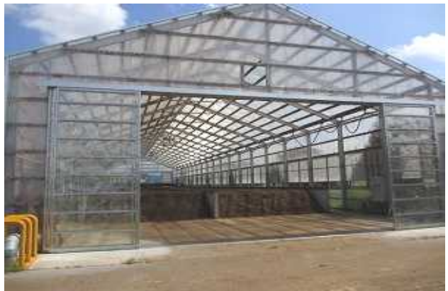
直線攪拌型堆肥舎 ▶
