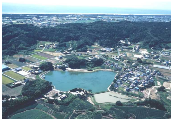
堤体の耐震補強を実施しているため池 居沼池
