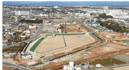
大雨時に流出水を貯留し、排水調整する調整池（磐田市西貝塚）
