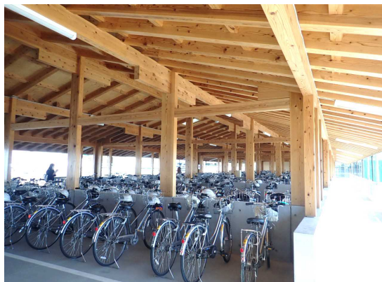
▲県産材を利用した木造駐輪場（御前崎市立浜岡中学校）
