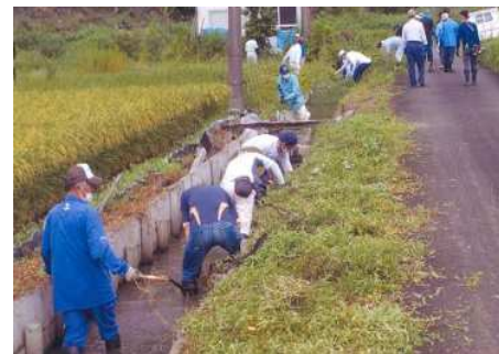
小坂環境保全協議会 水路の草刈り作業
