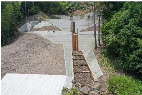
治山事業により整備された 溪間工施工地（静岡市葵区）
