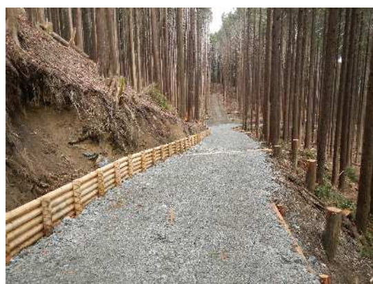
間伐・搬出に使用する森林作業道
