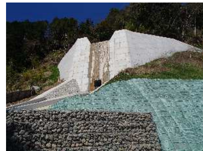
地すべり対策事業 長野南地区
