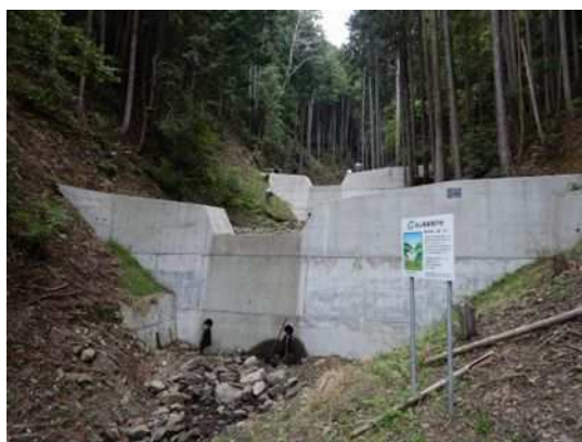
治山事業により整備された 溪間工 (静岡市葵区牛沢)
