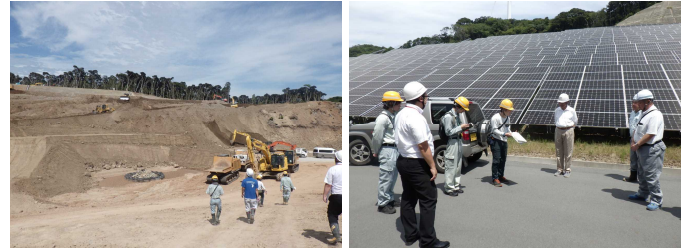
南伊豆町手石（施工中）
