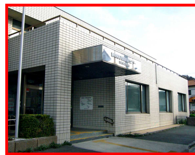
写真：松崎保健支援室外観
