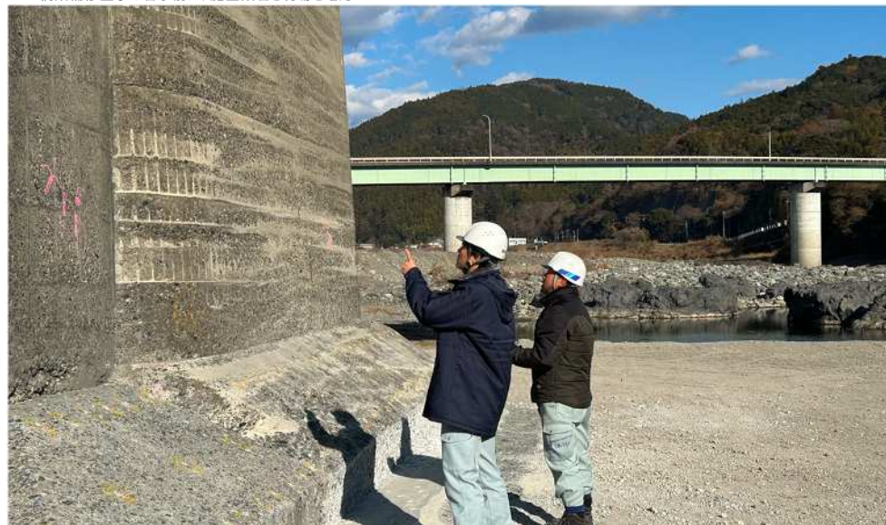
▼ 橋梁補修工事の着手前に、施工業者と現場を確認
