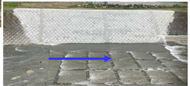
(二) 興津川 公共土木施設災害復旧事業 (静岡市清水区大平)
