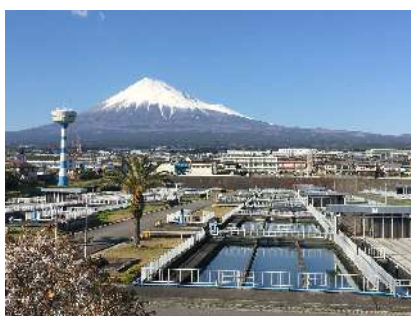
ふじさん工業用水道 厚原浄水場
