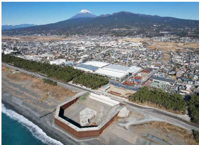
沼川新放水路〔整備中〕（沼津市）
