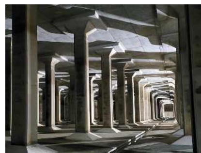
耐震化が完了した貯水施設
