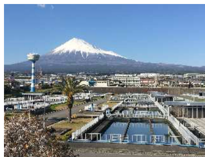
ふじさん工業用水道 厚原浄水場
