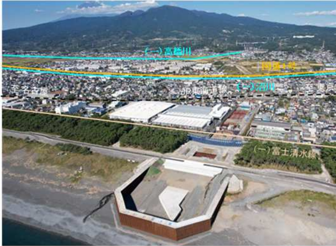
沼川新放水路〔整備中〕（沼津市）
