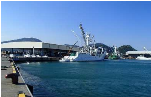
整備した大水深岸壁(焼津外港-9.0m西岸壁)
