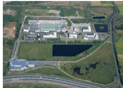
「狩野川西部浄化センター」（流域下水道事業）
