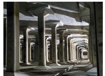
耐震化が完了した貯水施設
