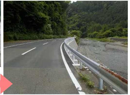
(一) 相俣岡部線 公共土木施設災害復旧事業 (藤枝市岡部町玉取)
