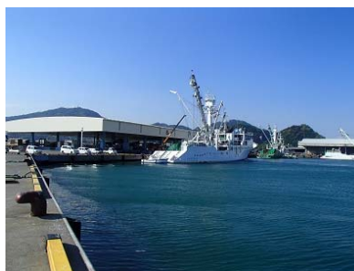
整備した大水深岸壁(焼津外港-9.0m西岸壁)
