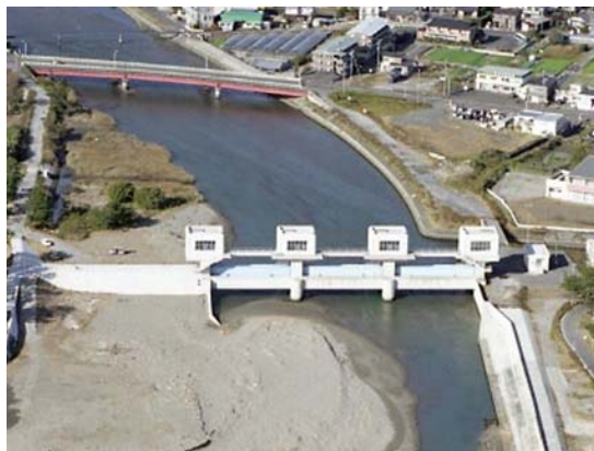
勝間田川水門
