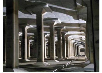
耐震化が完了した貯水施設
