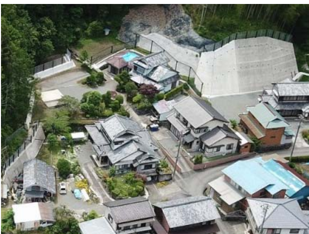
急傾斜地崩壊防止施設 （富士宮市）
