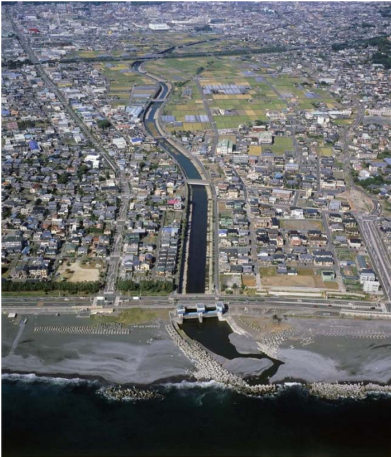
大谷川放水路（静岡市）
