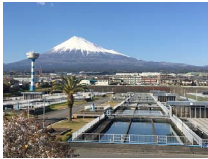
ふじさん工業用水道 厚原浄水場
