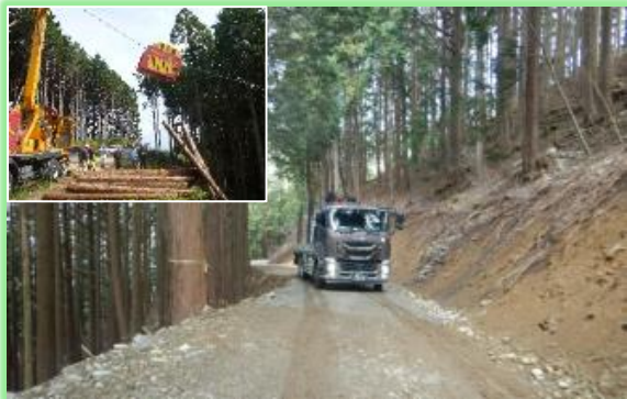
効率的に木材を搬出する基幹的作業道や架線集材施設
