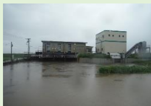
排水機場(毘沙門2期地区)
