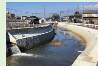
排水路整備(柿沢川南部地区)
