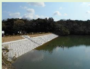
ため池の耐震工事
