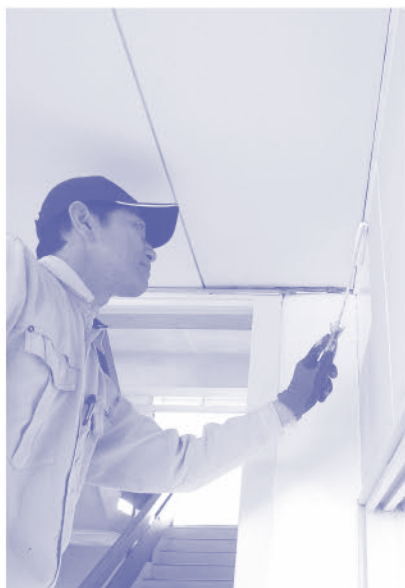
廊下の壁のペンキ塗りをする筆者
