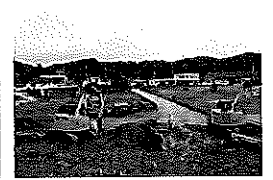
那珂川決壊場所 堤防内部に水道でき堤防外側崩壊で護岸倒壊 大量土砂の復旧作業 埼玉県川越市 越辺川
