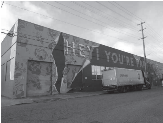
会社・倉庫の外観
