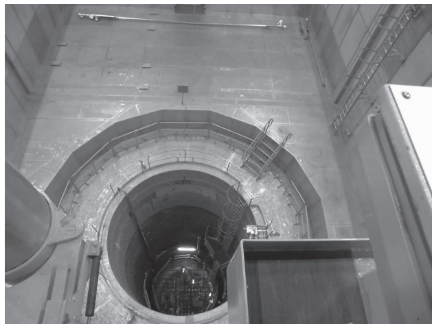
格納容器を上部から撮影
