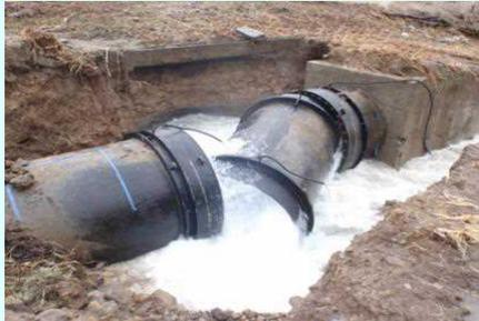
伸縮可とう管の抜き出し(鋼管2,400mm)
