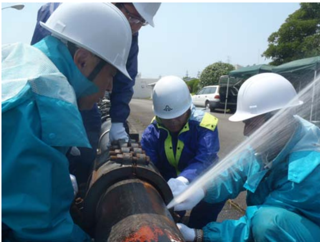
漏水補修金具を用いた漏水修繕実習
