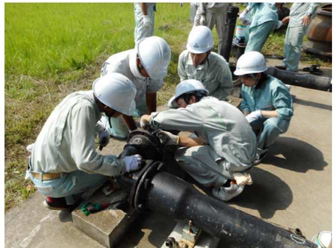
水道管接合実習
