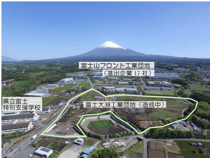
▲富士大淵工業団地造成箇所（令和3年4月撮影）
