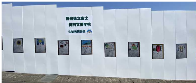
▲造成現場西側市道沿いの仮囲い
