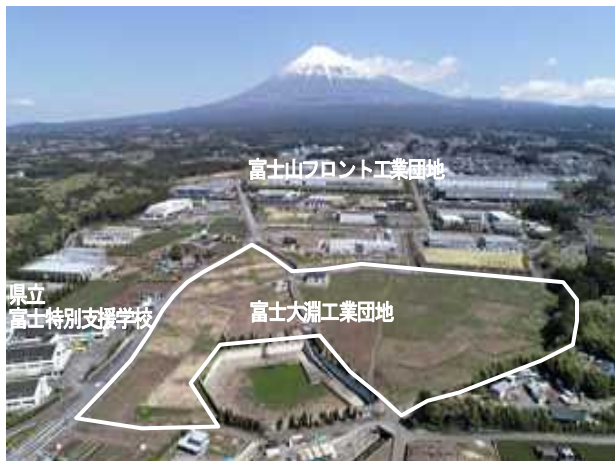
▲「富士大淵工業団地」造成地
