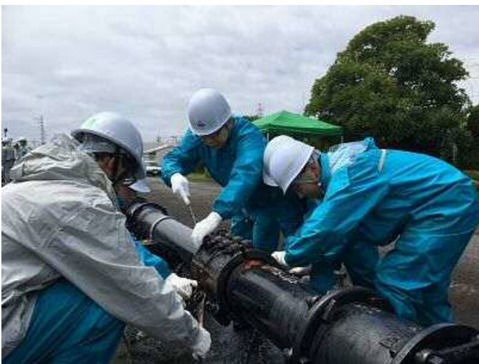
漏水補修金具を用いた漏水修繕実習
