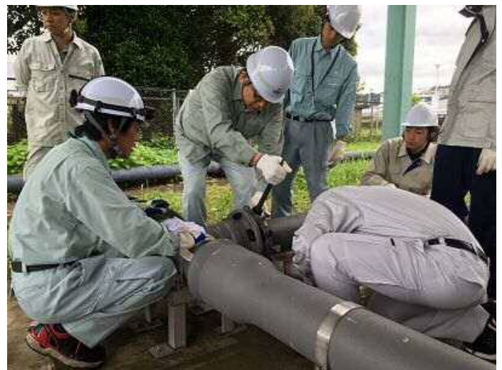
水道管接合実習
