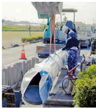
▶基幹管路を耐震性に優れた管に取り替えている様子
