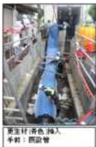
既設管の内面に更生材で、 自立耐震管に形成
