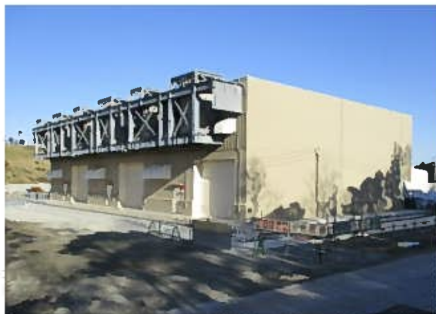
緊急時ガスタービン発電機建屋
