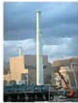
排気筒 改造工事
