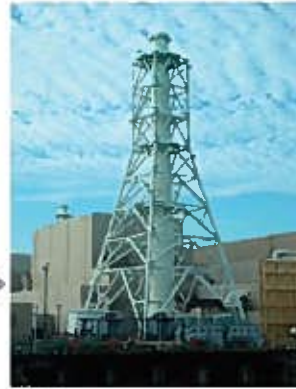
緊急時ガスタービン 発電機建屋
