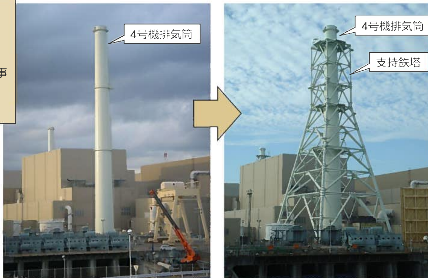
排気筒改造工事の例
