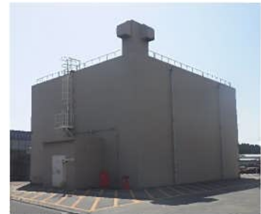
緊急時海水取水ポンプ室
