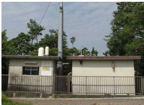
モニタリングステーション (空間放射線量率の測定)
