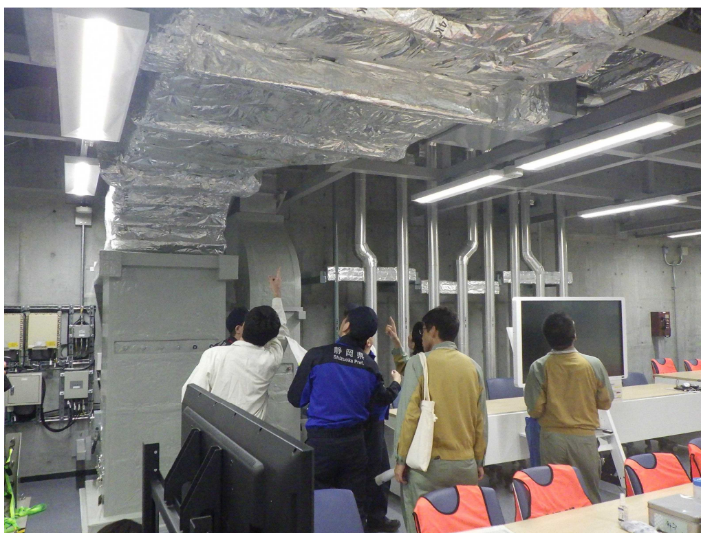
火災感知設備の設置状況の点検の様子
