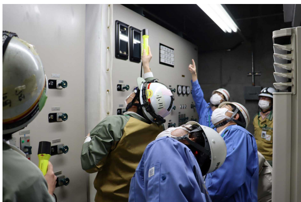
耐火隔壁の設置状況を確認
