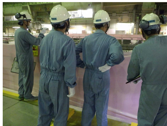
サイフォンブレイク孔の設置配管を確認
