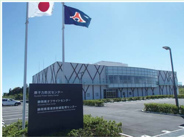
▲ 原子力防災センター外観
