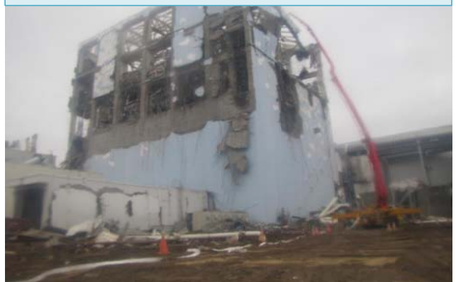
福島第一原子力発電所 4号機注水作業
