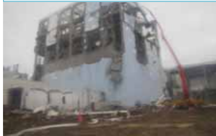
福島第一原子力発電所 4号機注水作業
