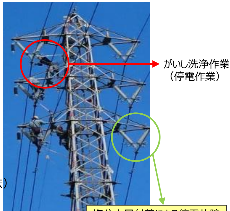
塩分大量付着による停電故障
