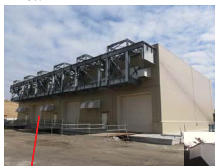
緊急時ガスタービン発電機建屋 (免震構造)
