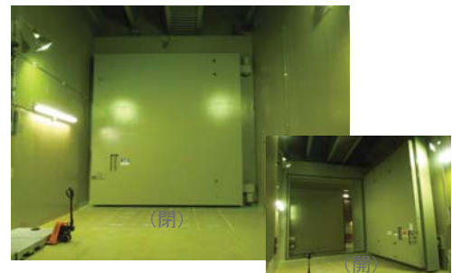
＜原子炉建屋大物搬入口の例＞
