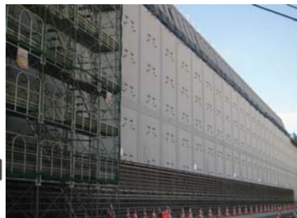
津波防護施設(防波壁)設置状況
