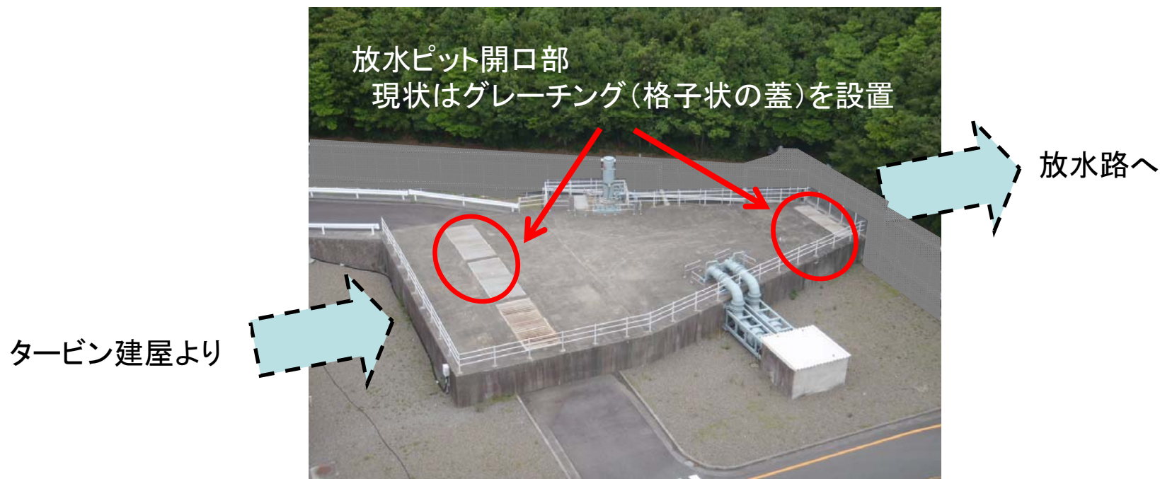
放水ピット開口部 の具体例(4号機)
