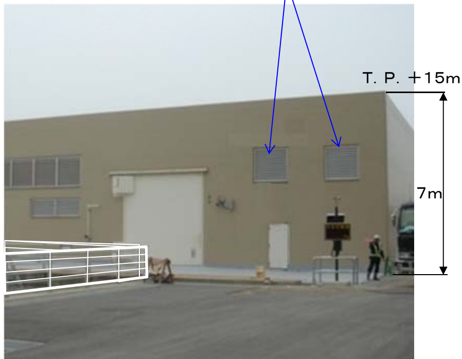
海水熱交換器建屋 改造前 (高さは5号機の例)
