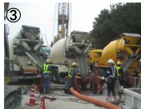
コンクリート打設作業
