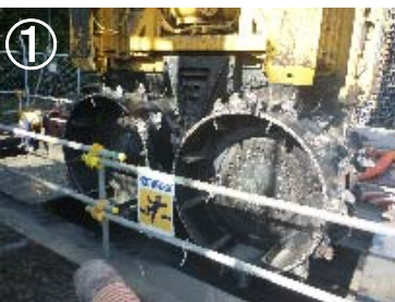
基礎部掘削作業
