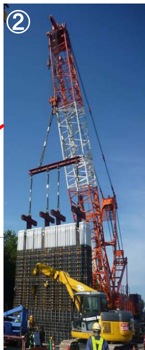
鉄筋建て込み作業
