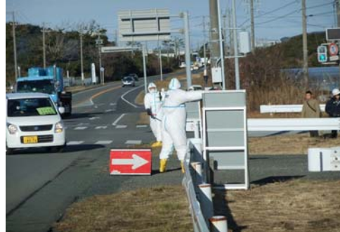
車両の引き込み
