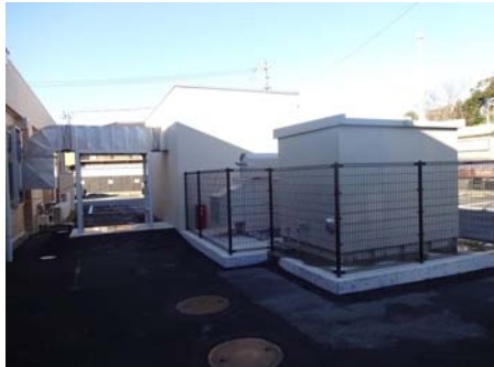
陽圧浄化ユニット建屋
